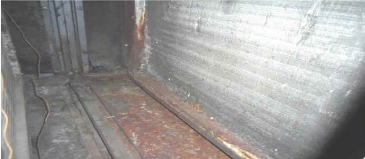
Abb. 3 Oberflächenkorrosion in einem RLT-Gerät
